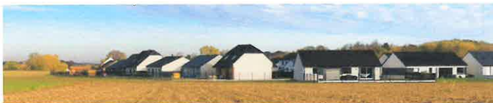
Figure 106 : Lotissement de Récourt en novembre 2020
